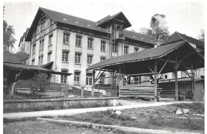
Das Schreinerei-Gebäude mit dem Holzlagerplatz. Mann beachte den Warenlift an der Fassade
